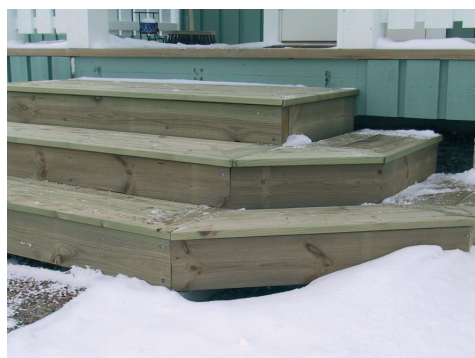
Trappa byggd i impregnerat trä.
